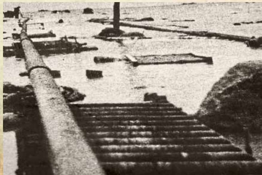
УКЛАДКА НЕФТЕПРОДУКТОПРОВОДА КАРЕДЖА — БОРИСОВА ГРИВА ПО ДНУ ЛАДОЖСКОГО ОЗЕРА ВЕСНОЙ 1942 ГОДА
