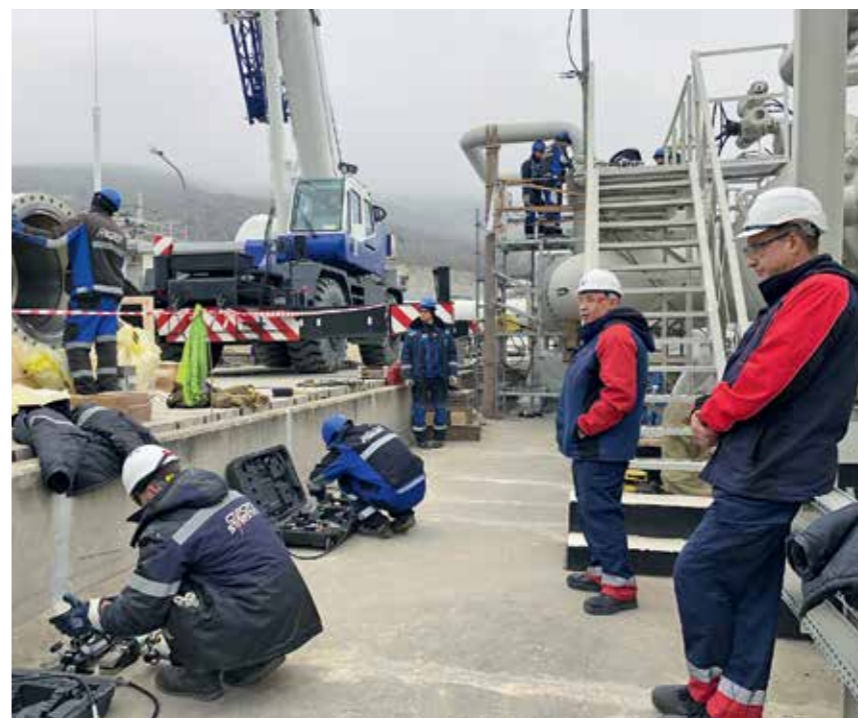
ЗАМЕНА ШАРОВОГО КРАНА КППС, 2020
