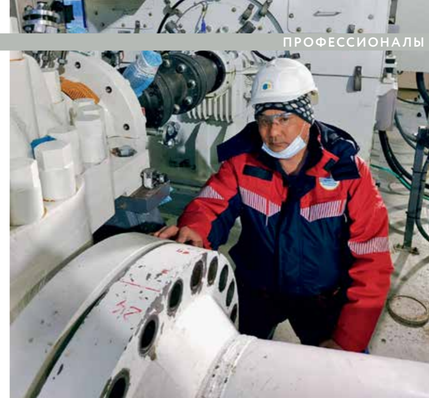
В МАГИСТРАЛЬНОЙ НАСОСНОЙ, 2020 ГОД
