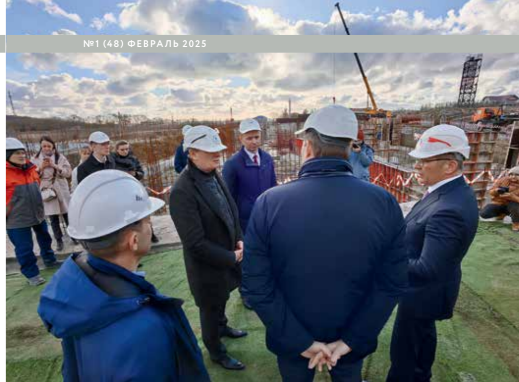
СТРОИТЕЛЬСТВО КЭЦДМ В ЮЖНОЙ ОЗЕРЕЕВКЕ
