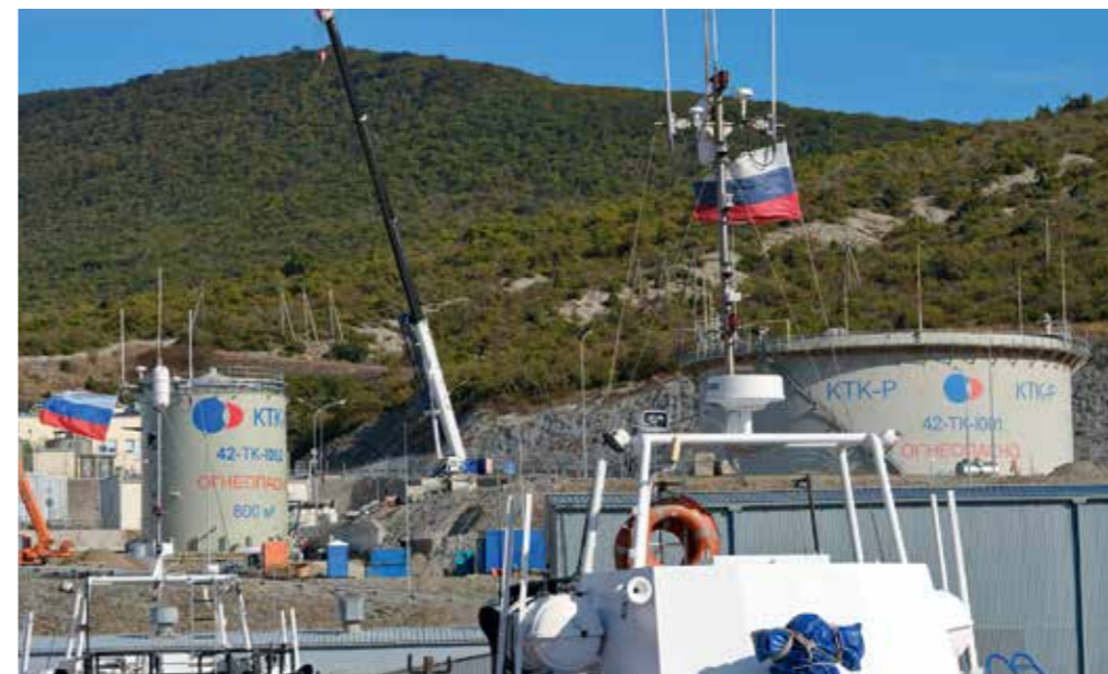
НОВЫЙ МНОГОЦЕЛЕВОЙ РЕЗЕРВУАР БС (СЛЕВА) И ИСПОЛЬЗУЕМЫЙ ПРЕЖДЕ (СПРАВА)
