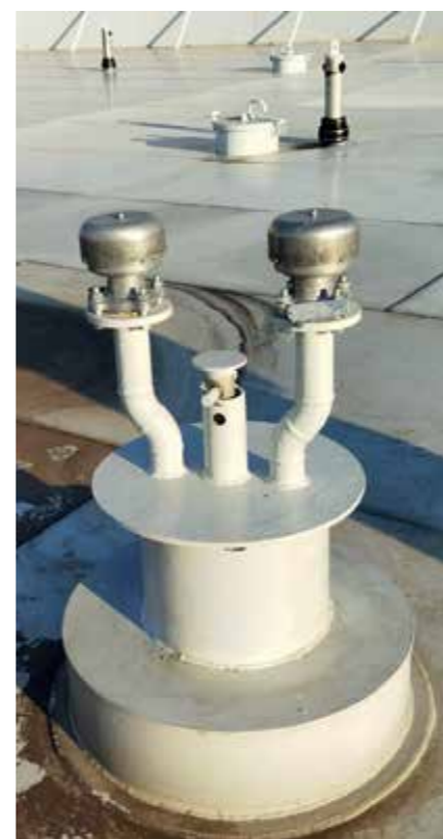
МОДЕРНИЗИРОВАННЫЙ АВТОМАТИЧЕСКИЙ ВЫПУСКНОЙ КЛАПАН РВСПК-100000
