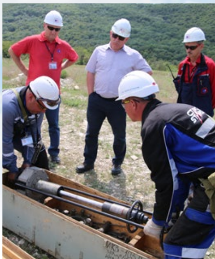
Представители подрядной организации демонстрируют оборудование для работы на трассе
