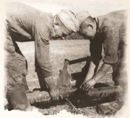
Монтаж полевого трубопровода
