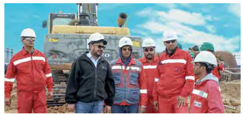
Аджит Манку на строительстве А-НПС-4
